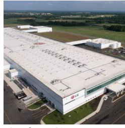
Gambar 3 Pabrik sel Baterai EV Indonesia
